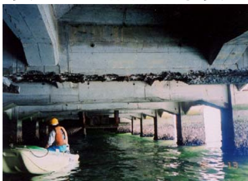
【施設の点検①】
