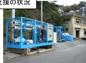
海水淡水化装置設置状況
