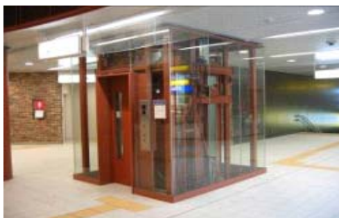
エレベーター(段差解消)
