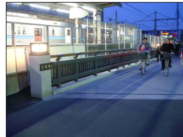
【整備後の三鷹橋】
