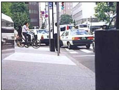
段差、傾斜、勾配の改善
