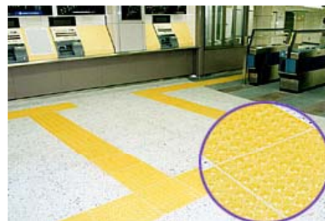
視覚障害者誘導用ブロック
