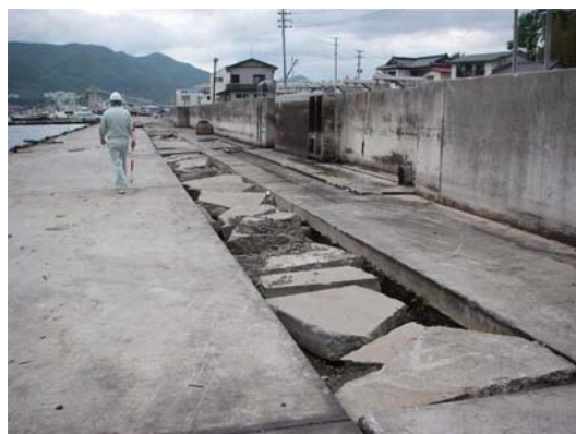
図-I-2.6(a) 大船渡港山口地区における物揚場舗装の被害 (左) とその被災断面図 (右)
