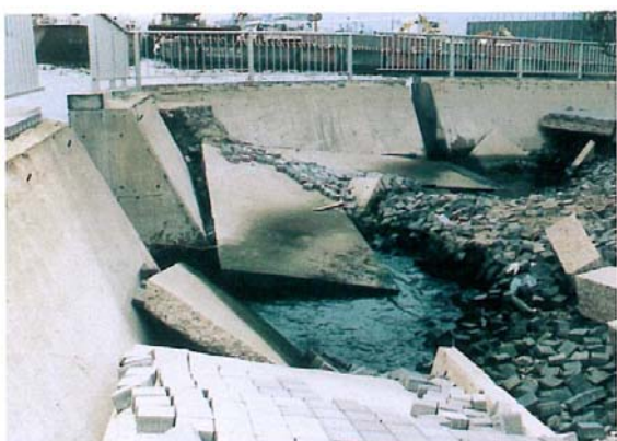
写真-I-2.3(e) 護岸被害（灘浜地区）
