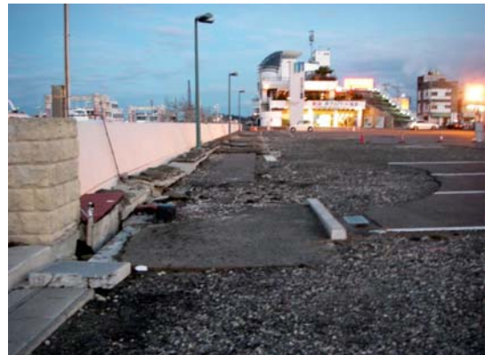
図-I-2.12 仙台塩釜港塩釜港区港地区における胸壁周辺の海側地盤の洗掘（左）と陸側地盤の洗掘（右）
