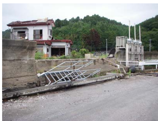
図-I-2.10 荻浜港荻浜地区における胸壁の被災状況（左）と被災断面図（右）
