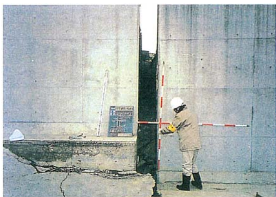
写真-I-2.3(c) 護岸被害
