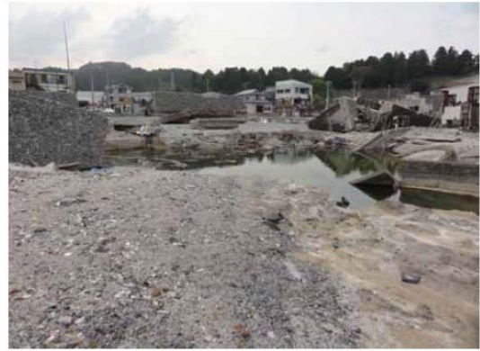
写真- I -2. 2 山田漁港における胸壁の被災事例
