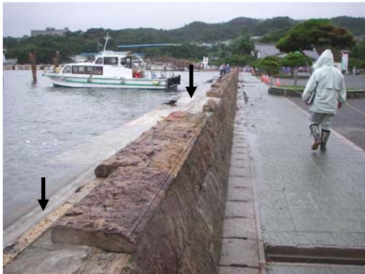
図-I-2.11 松島港海岸前地区における胸壁の化粧板の剥がれ（左）と被災断面図（右）
