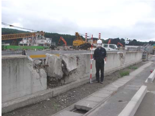
図-I-2.7(a) 気仙沼港朝日地区における一部欠損した胸壁の状況(左)と被災平面図(右)
