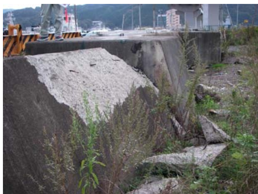
図-I-2.5(b) 釜石港須賀地区における角部の欠損状況（左）と被災断面図（右）
