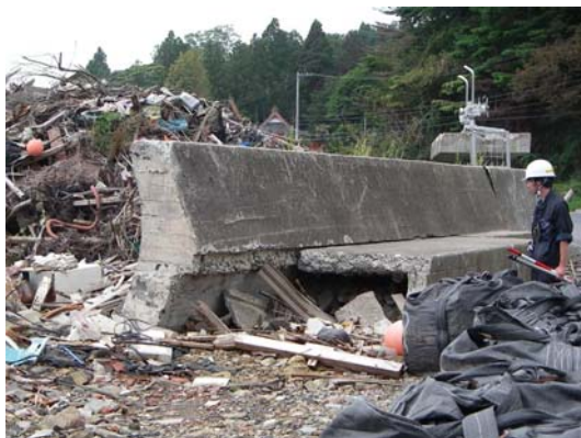
図-I-2.8 雄勝港大浜地区における胸壁の倒壊(左)と胸壁背面側の洗掘(右)
