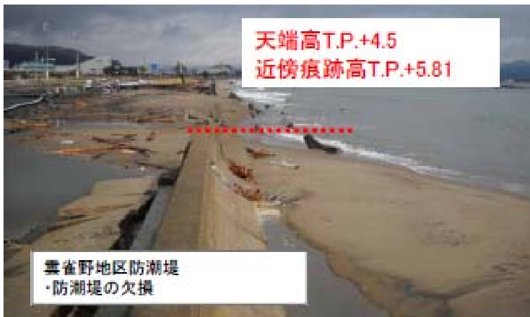
写真-I-2.1 石巻港雲雀野地区における防潮堤の被災事例
