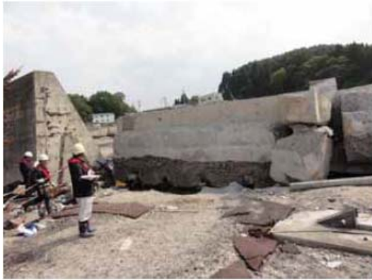
写真- I -2. 2 山田漁港における胸壁の被災事例
