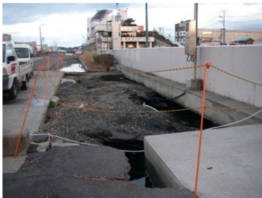
図-I-2.12 仙台塩釜港塩釜港区港地区における胸壁周辺の海側地盤の洗掘（左）と陸側地盤の洗掘（右）
