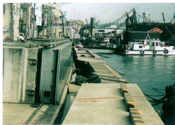
写真-I-2.3(d) 物揚場被害（島上町地区洲）
