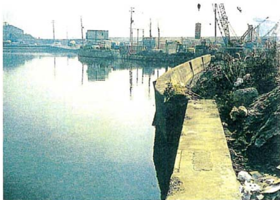
写真-I-2.3(a) 護岸被害（大高洲）
