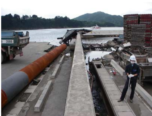
図-I-2.7(b) 気仙沼港朝日地区における胸壁堤体直下の地盤流出による被災状況(左)と被災断面図(右)
