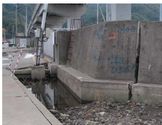
図-I-2.5(a) 釜石港須賀地区隅角部における被災状況（左）と被災断面図（右）
