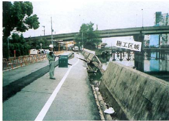
写真-I-2.3(b) 護岸被害（兵庫運河）
