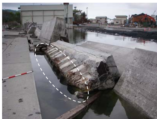
図-I-2.6(b) 大船渡港茶屋前地区における堤体の倒壊の状況 (左) と被災断面図 (右)
