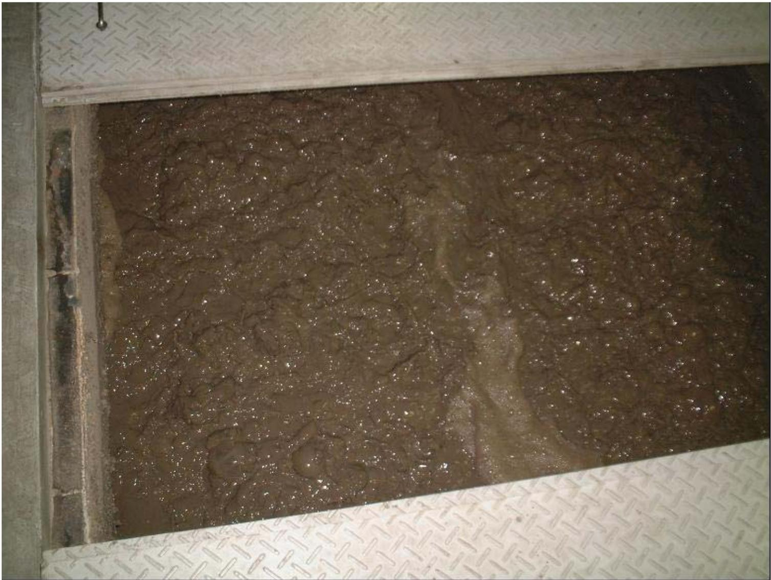
エアレーションを停止した微生物生物反応槽を上から見たところ(膜ユニットが見える)
