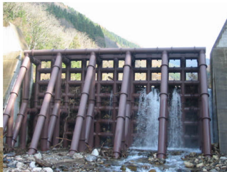
流木を捕捉した菅沼谷えん堤 (岐阜県飛騨市)
