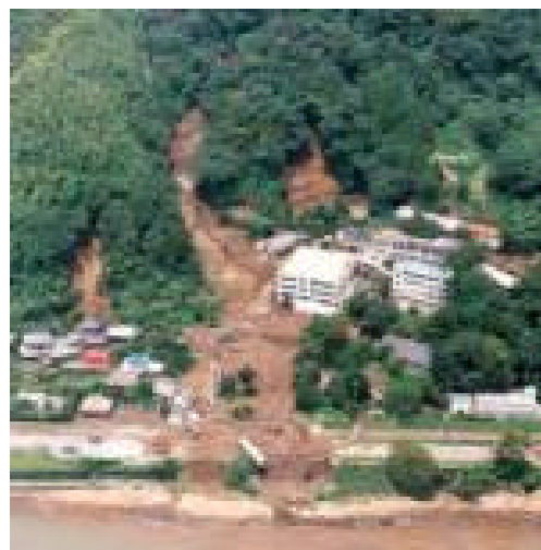
H 5 梅雨前線豪雨により花倉病院が被災 (死者 16 名：鹿児島県)
