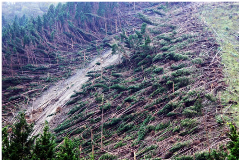
風倒木の状況 岡山県勝山町)
