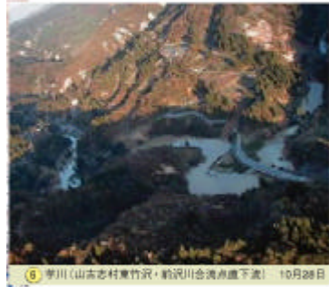
⑥ 芋川(山古志村東竹沢・粕沢川合流点直下流) 10月28日
