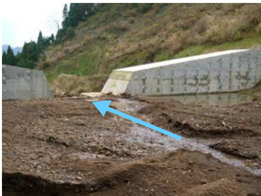
土石流を捕捉したコンクリートスリット砂 防えん堤 (H16年 9月 福井県池田町)
