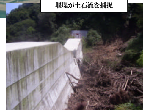
堰堤が土石流を捕捉
