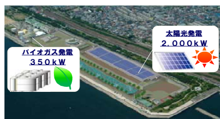
図 30 施設上部や敷地の貸付による太陽光・消化ガスのダブル発電事業の事例
