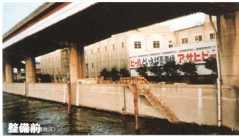
隅田川 吾妻橋地区の例 (東京都)
