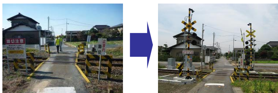
図1：踏切遮断機・警報機の整備
