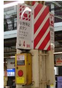
図3: 非常停止押しボタン
