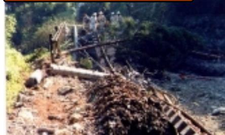
基礎部分が洗い流されて落ちている線路
