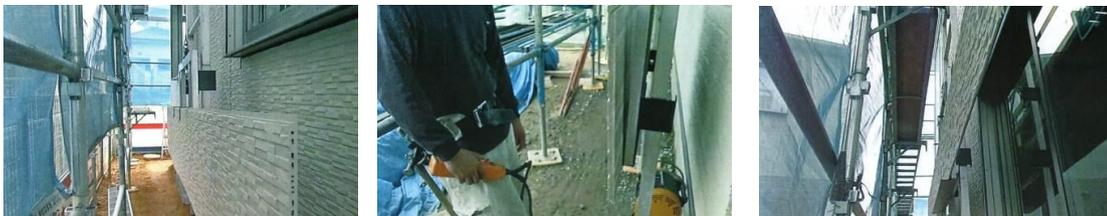
既設の足場に昇降用レールを設置し、ウインチによりサイディングを荷揚する装置を試作した。試作品では厚さ16mmのサイディング（1枚あたり約26～27kg）を同時に3枚まで荷揚可能である。
