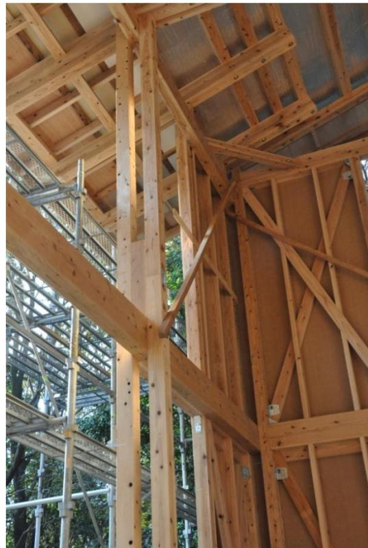
外柱は100角×7mの通し柱を使用。管柱はダボ継手
