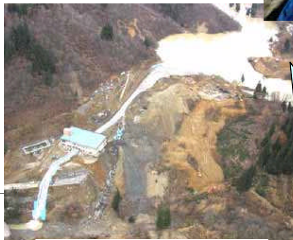
写真④ ポンプ排水吐口部の付け替え完了
