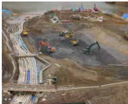
写真⑤ 仮排水路工 (開水路) 施工状況 (国土交通省)
