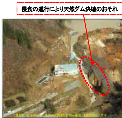
写真② ポンプ排水吐口部の侵食状況 (11/17)
