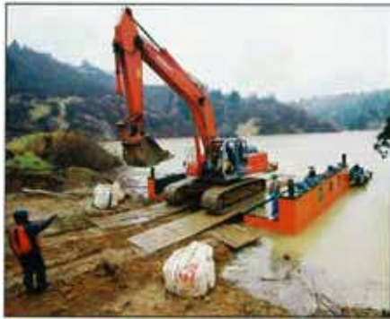
写真① 台船による重機の運搬状況 (11/14) (国土交通省)
