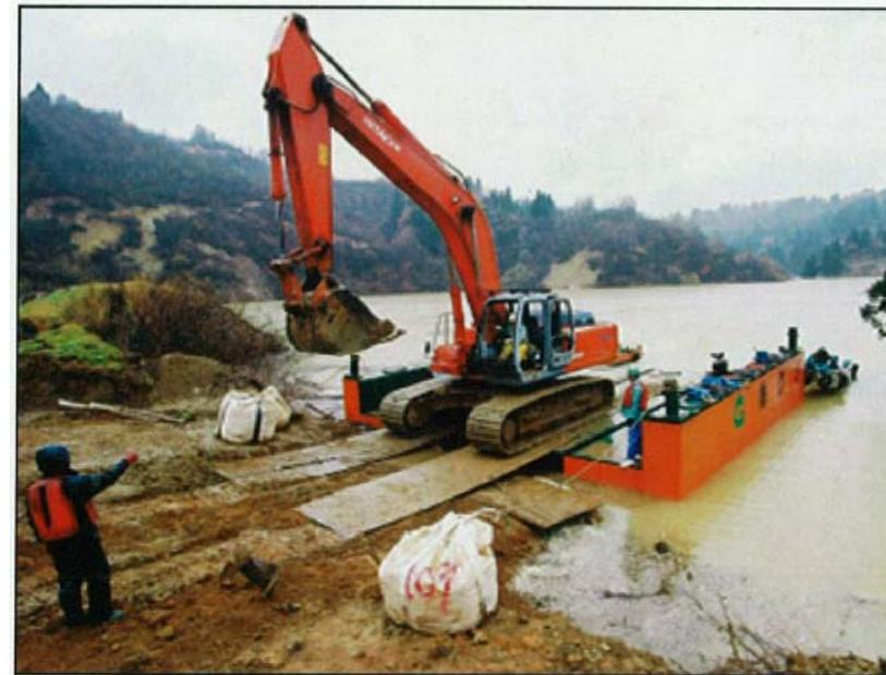
写真① 台船による重機の運搬状況(11/14)
