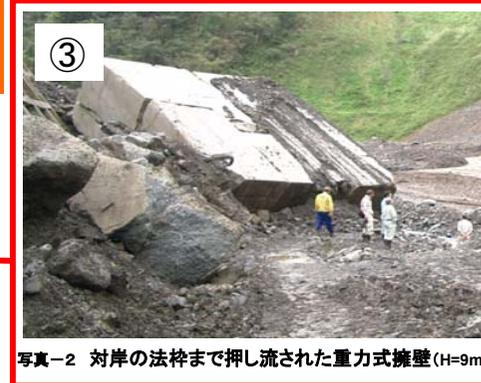
写真-2 対岸の法枠まで押し流された重力式擁壁(H=9m)
