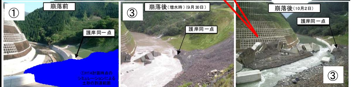
写真-4 重力式擁壁 状況写真
