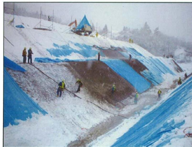
写真③ 仮排水路工(開水路)施工状況
