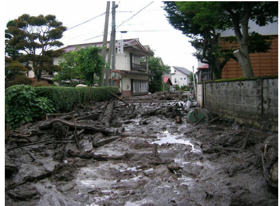
写真 小田井沢川下流(岡谷市湊3丁目)の道路に堆積した土砂
