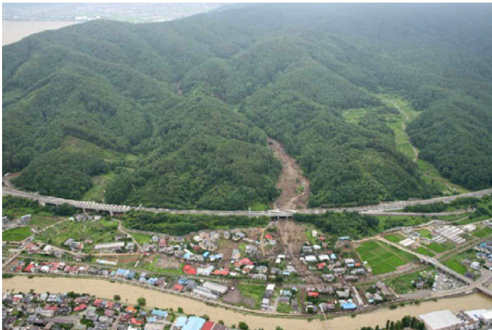
写真 志平川(岡谷市川岸2丁目)土石流全景 (出典：長野県豪雨災害に関する航空写真 平成18年7月 PASCO)
