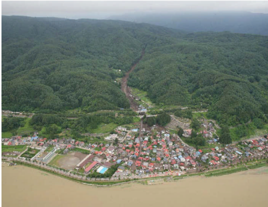
写真 小田井沢川(岡谷市湊3丁目)土石流全景
