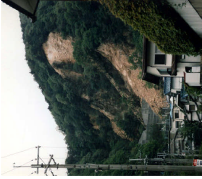
写真 住吉台山腹崩壊全景 (出典：国土交通省河川局 HP)
