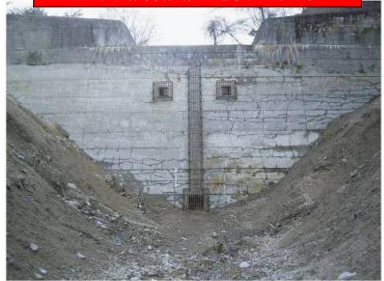
多量の流木を捕捉する鋼製砂防えん堤
