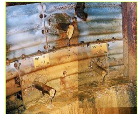
地すべり地内の地下水位を下げる集水ボーリングで目詰まりが発生した。機能維持のために洗浄が必要である。
