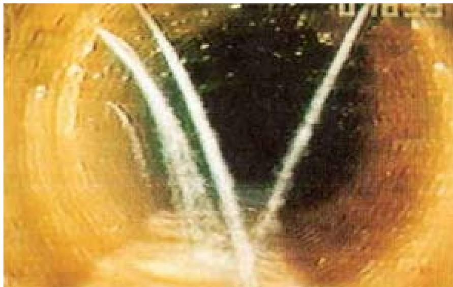
大口径排水ボーリング工の施工により、目詰まりが減少し、ライフサイクルコストが縮減する。20
