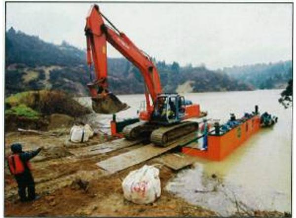
無人化施工機械による緊急措置
