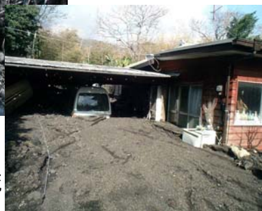
人家を埋塞した泥流
