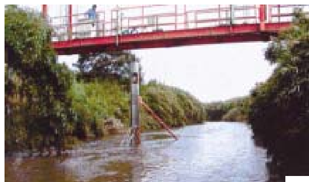
浮遊砂量のモニタリング (流砂量捕捉ポンプ)
