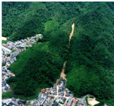
平成11年6月29日被災箇所
