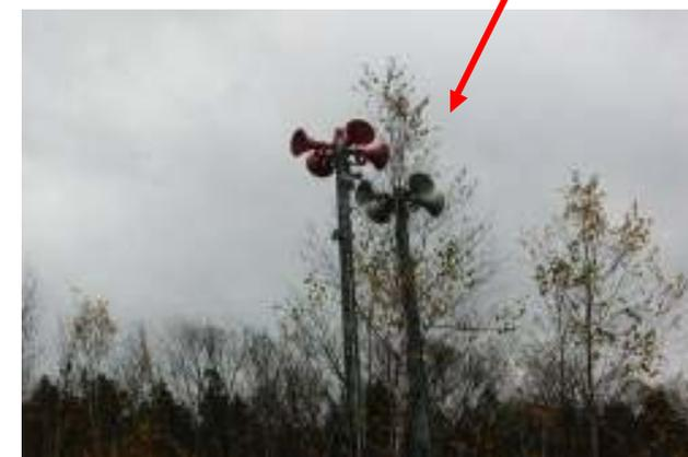
泥流検知センサーにより、泥流発生時には警報を鳴らす警報機(サイレン)を設置。【十勝岳】
