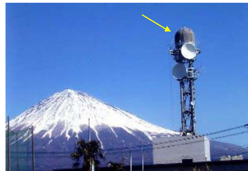
Xバンドレーダ雨量計 (富士砂防事務所屋上)
