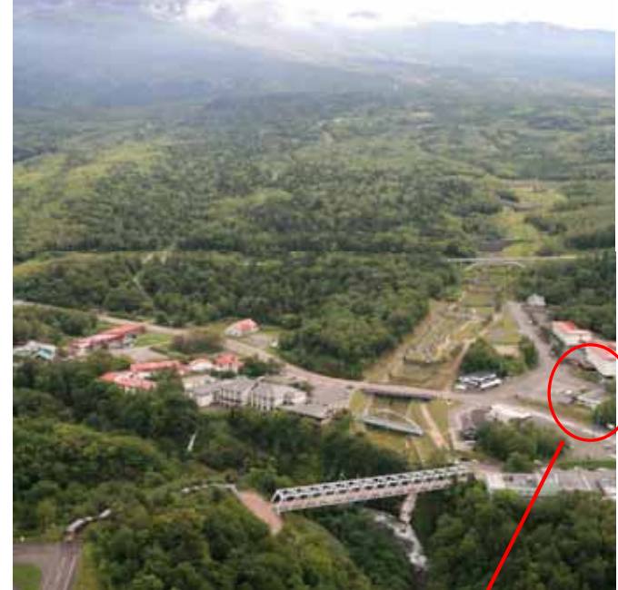
警報機の設置
