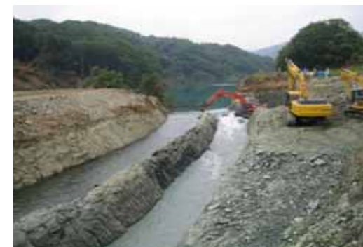
水路の拡幅工完了 (7月5日)
