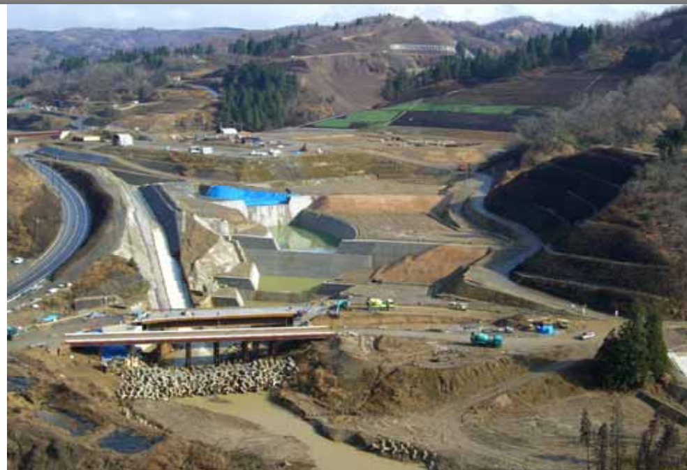
完成した砂防えん堤と流路工 (中越地震 東竹沢地区)
