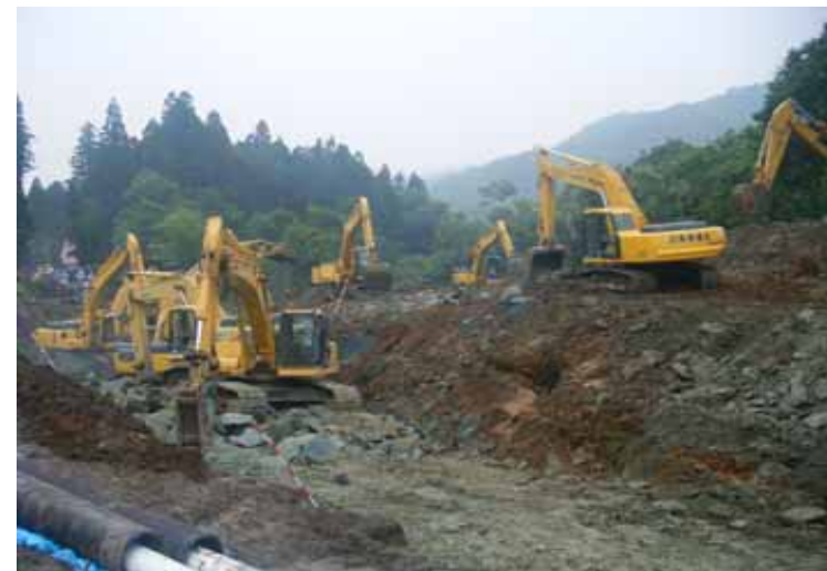
掘削して仮排水路を設置 (岩手・宮城内陸地震 市野々原地区)
