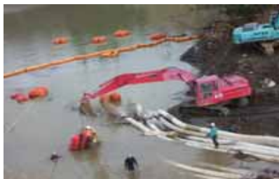
排水ポンプ設置状況
