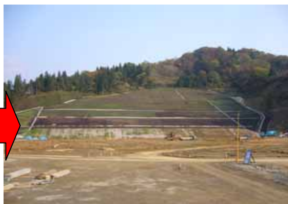
地すべり斜面の法面对策(東竹沢地区) (左:平成17年7月30日 右:平成18年11月1日)
