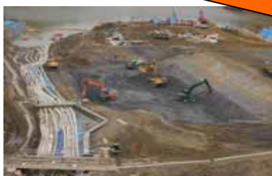
仮設排水路作設状況
