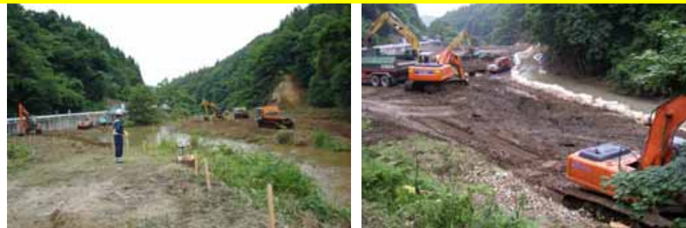
堆積土砂の除石
