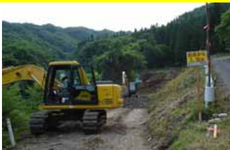
進入路造成 (6月25日～)
