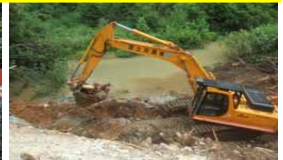
無人バックホウによる掘削
