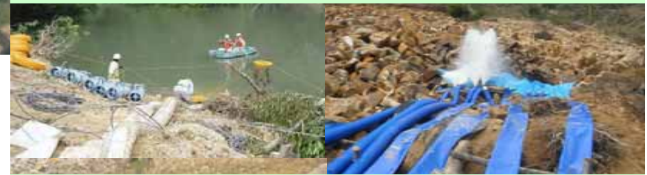
ポンプによる強制排水状況
