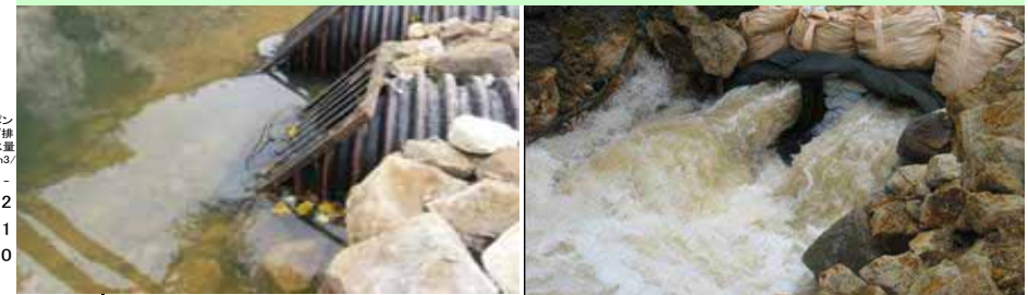
仮排水路管呑口・吐口の状況
