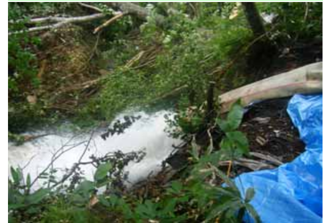
排水ポンプによる強制排水を実施 (6月19日～22日)
