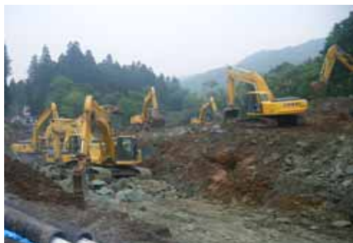
河道閉塞(天然ダム)対策工事着手 (6月17日～)
