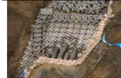
排水路管出口状況
