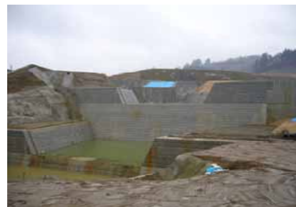
砂防えん堤(東竹沢地区)
