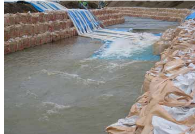
ポンプによる強制排水を実施 (岩手・宮城内陸地震 小川原地区)
