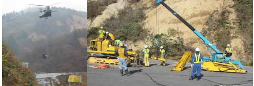
◆バックホウの分解、ヘリによる空輸、現地組立を実施
