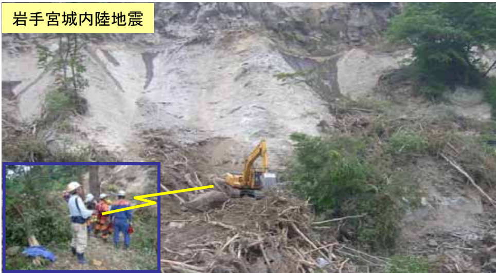
◆危険箇所に無人化施工機械を使用
