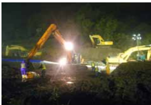
24時間態勢で仮排水路掘削工事を実施 (6月18日～26日)
