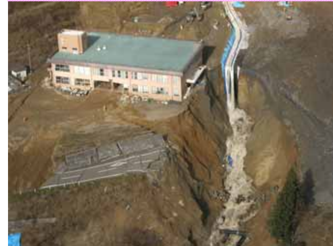
【写真】ポンプ排水でさえ侵食して河岸が後退
