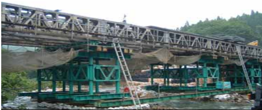
◆工事用道路として仮設橋を設置（13日間で設置）
