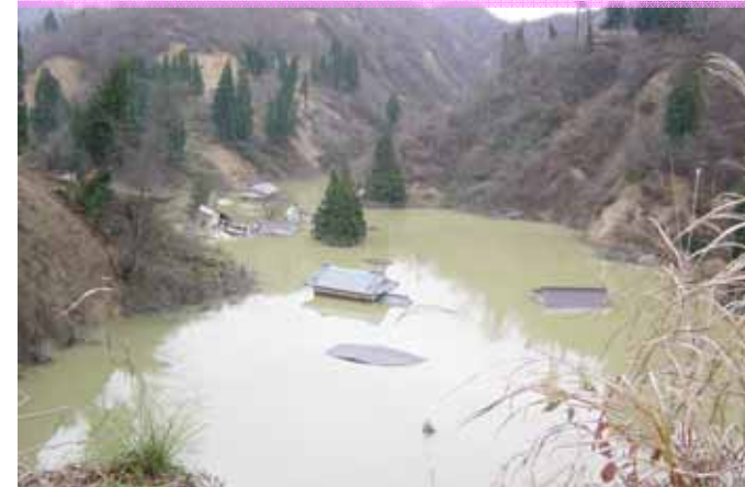
【写真】湛水した木籠地区 (平成16年11月29日)
