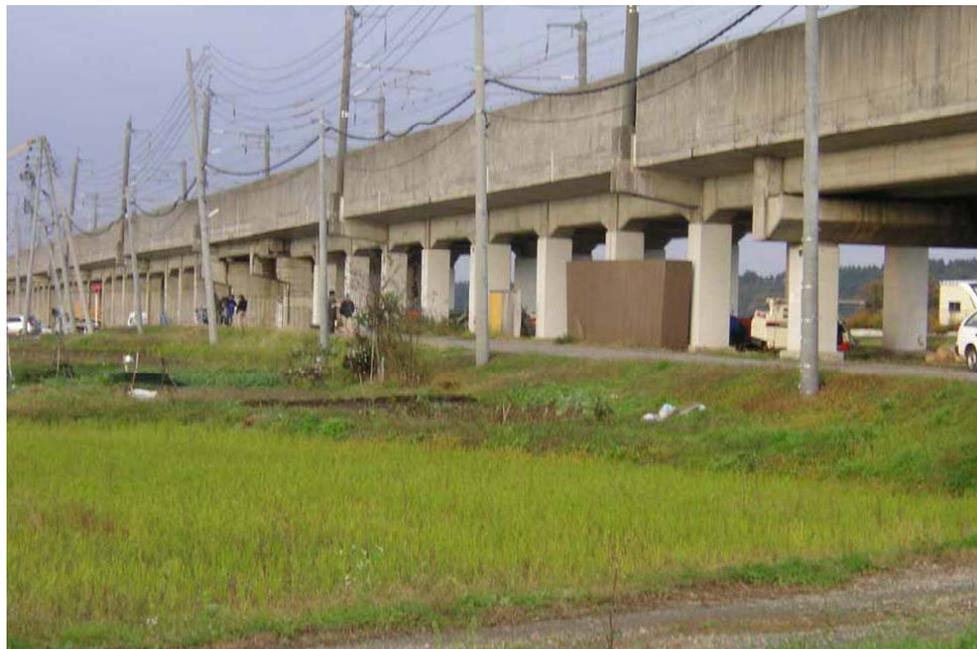
図 鉄板巻コンクリートで予め補強してあった高架橋の橋脚
