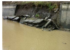
側壁が倒壊した水路
