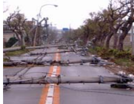
(台風による道路の被災状況)
