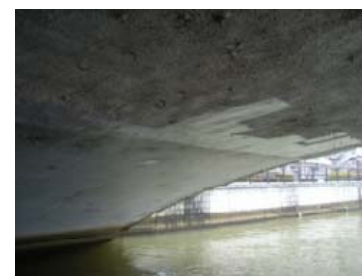
H22修繕後 (主桁修繕)
