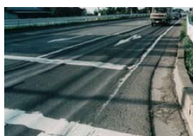
(舗装のわだち掘れ)
