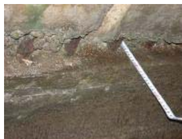
H22損傷状況 (主桁剥離)
