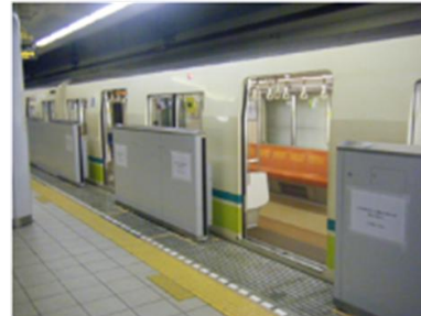
出典：大阪市交通局HP 可動式ホーム柵の実施
