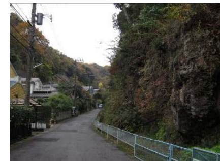
樹木管理事業により沿道が除伐された道路(鎌倉市)
