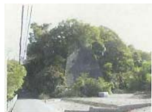
土砂崩壊防止施設 (鎌倉市)
