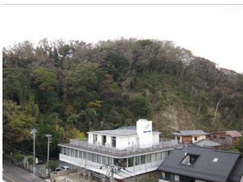
住宅地近傍の土砂崩れ（鎌倉市）
