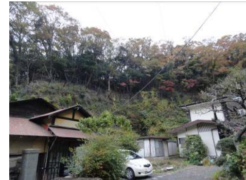
住宅近接地での落石防止ネット工 (鎌倉市)
