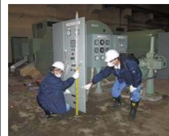
現地調査状況
