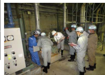
災害査定状況
