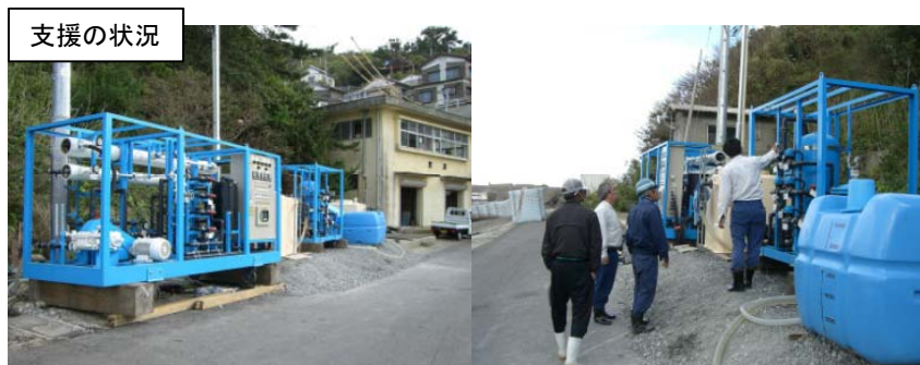
海水淡水化装置設置状況
