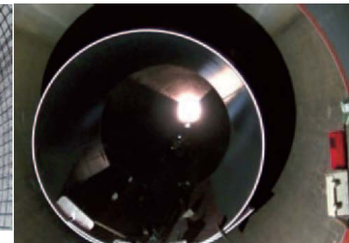
サイホン内に鋼管を挿入し補強
