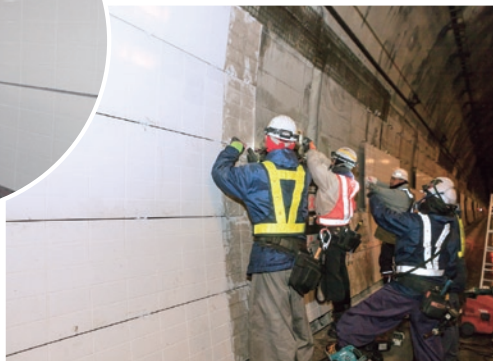
新しい内装板の設置作業。(平成26年2月撮影)
