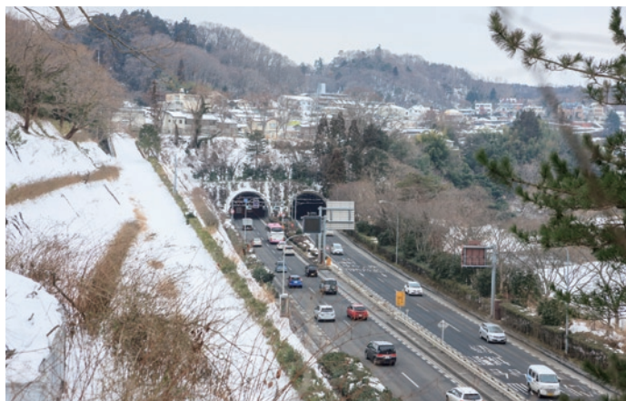
上り側から見た青葉山トンネル入口
