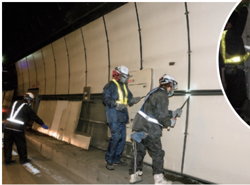
古い内装板の撤去作業の様子。外したパネルはホコリが立たないように水を拭きかける。(平成25年11月撮影)
