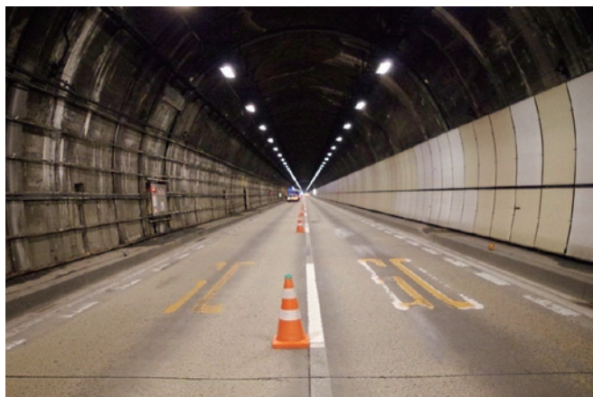
写真左側は内装板を撤去した跡。右側にはまだ古い内装板が残る。(平成25年11月撮影)
