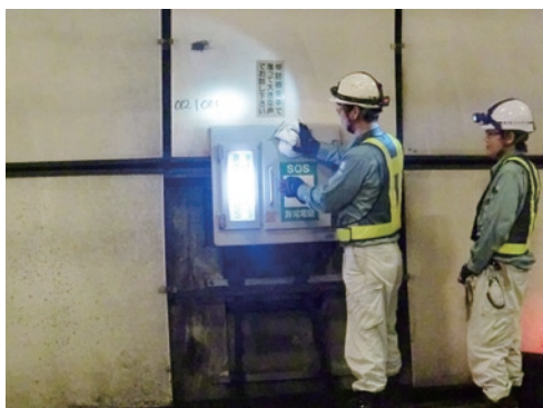
最近では携帯電話の普及によりあまり使われなくなったが、非常電話も緊急事態に備えて念入りに点検。(平成25年8月撮影)
