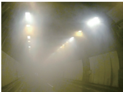
スプリンクラー検査。実際に水を噴射して点検。(平成25年8月撮影)
