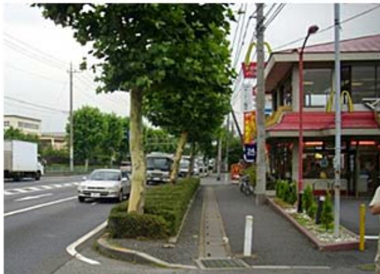
<対策後:街路樹を剪定して見通しを確保>
