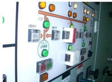
エラー防止の手作りカバー (発砲スチロール製)
