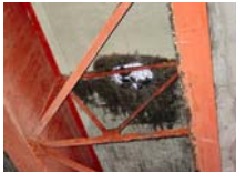
(橋梁の抜け落ち)
