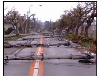
(台風による道路の被災状況)
