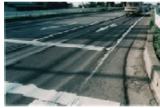
(舗装のわだち掘れ)
