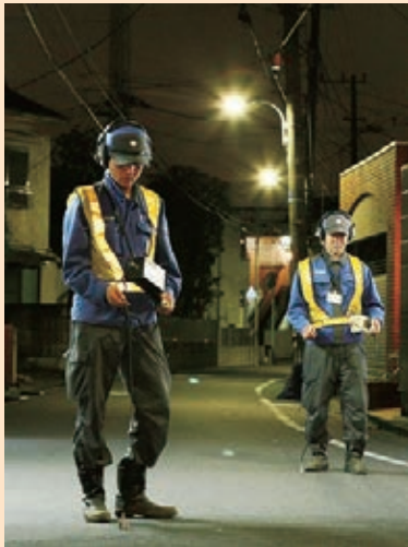
夜間水道管漏水調査 写真提供：東京都水道局
