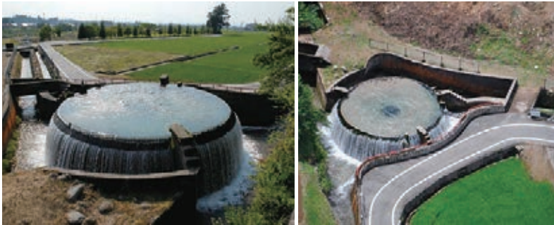
円筒分土工（富山県魚津市）写真提供：魚津商工会議所
