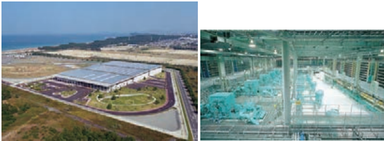
福岡県福岡市東区奈多に建設された海水淡水化施設。 最大生産水量は 50,000 \text{m}^3 /日 で国内最大規模の施設。 写真提供：福岡地区水道企業団
