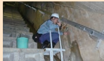
ダム堤内の漏水測定（下久保ダム） 写真提供：（独）水資源機構
