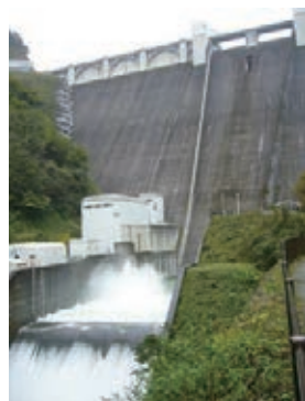
水力発電（ダム） 浦山ダムではダムから放流する水を有効活用して、水力発電所で電気をつくっています。 （写真：浦山ダム（独）水資源機構）
