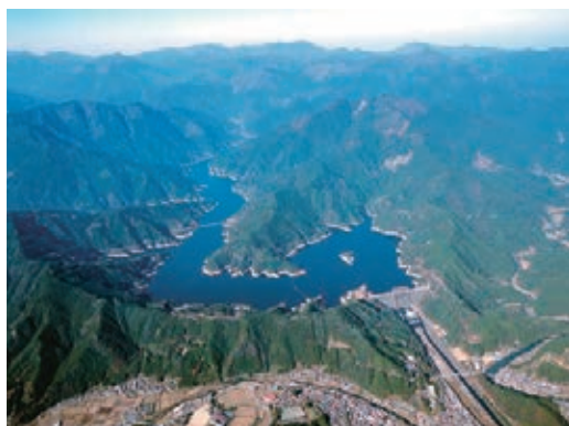
早明浦ダム（高知県） 独立行政法人水資源機構
