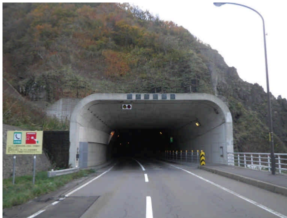
トンネル概観(起点側坑口)
