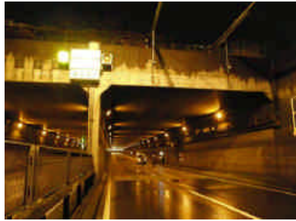
トンネル概観(下り)
