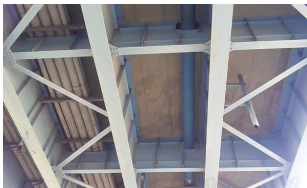
床版裏添架状況 1
