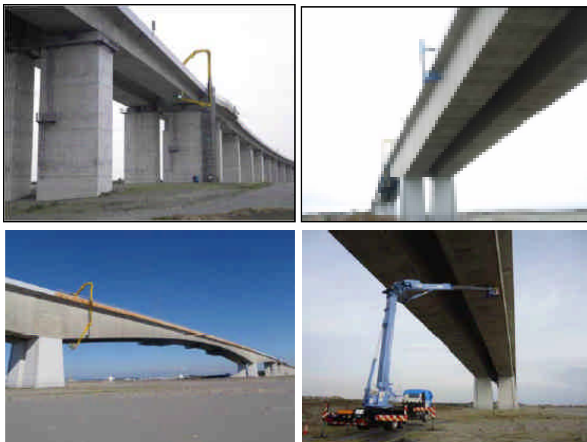
橋梁概観(点検状況)
