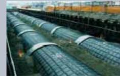
高強度炭素繊維グリッド、ポリマーセメントモルタルによりトンネル補強
