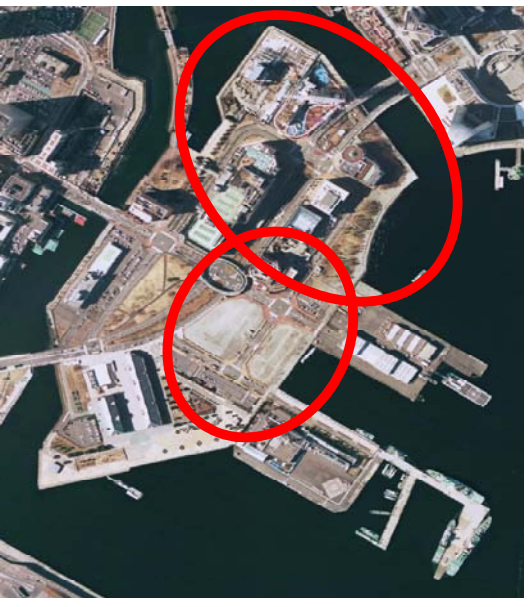
在来岸壁を廃止し、横浜海上防災基地や横浜ワールドポーターズ、横浜赤レンガ倉庫等の商業施設等を整備
