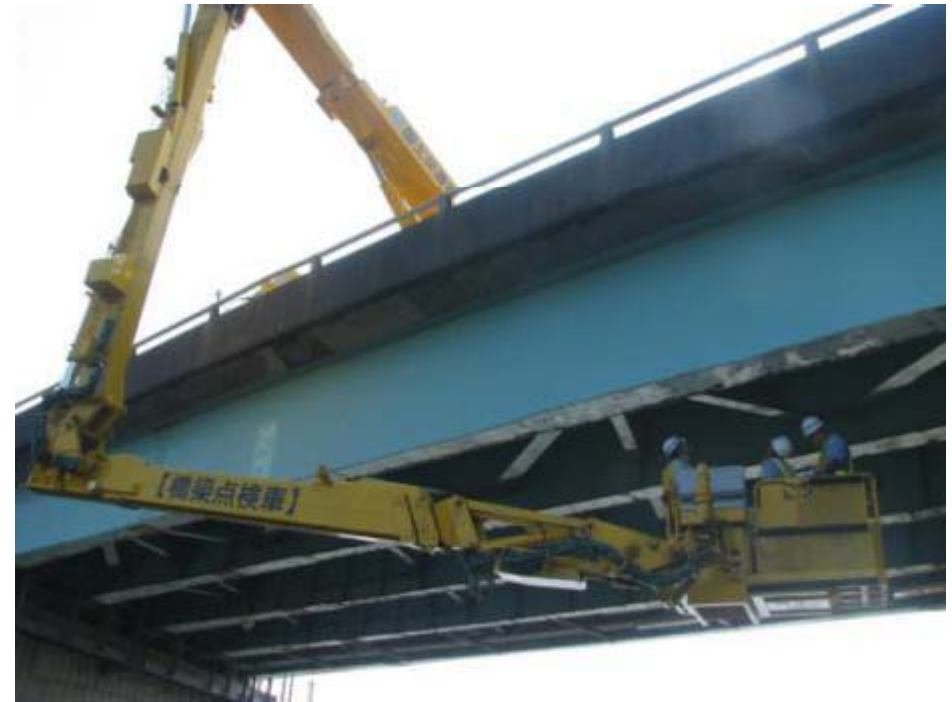
黒川大橋(北陸地方整備局)
