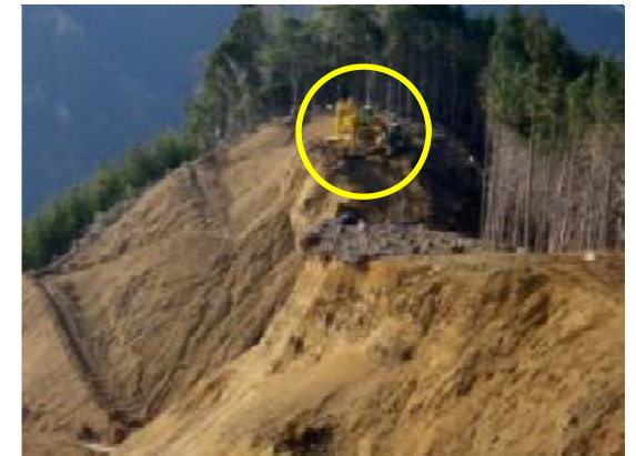
無人化施工の実施箇所状況
