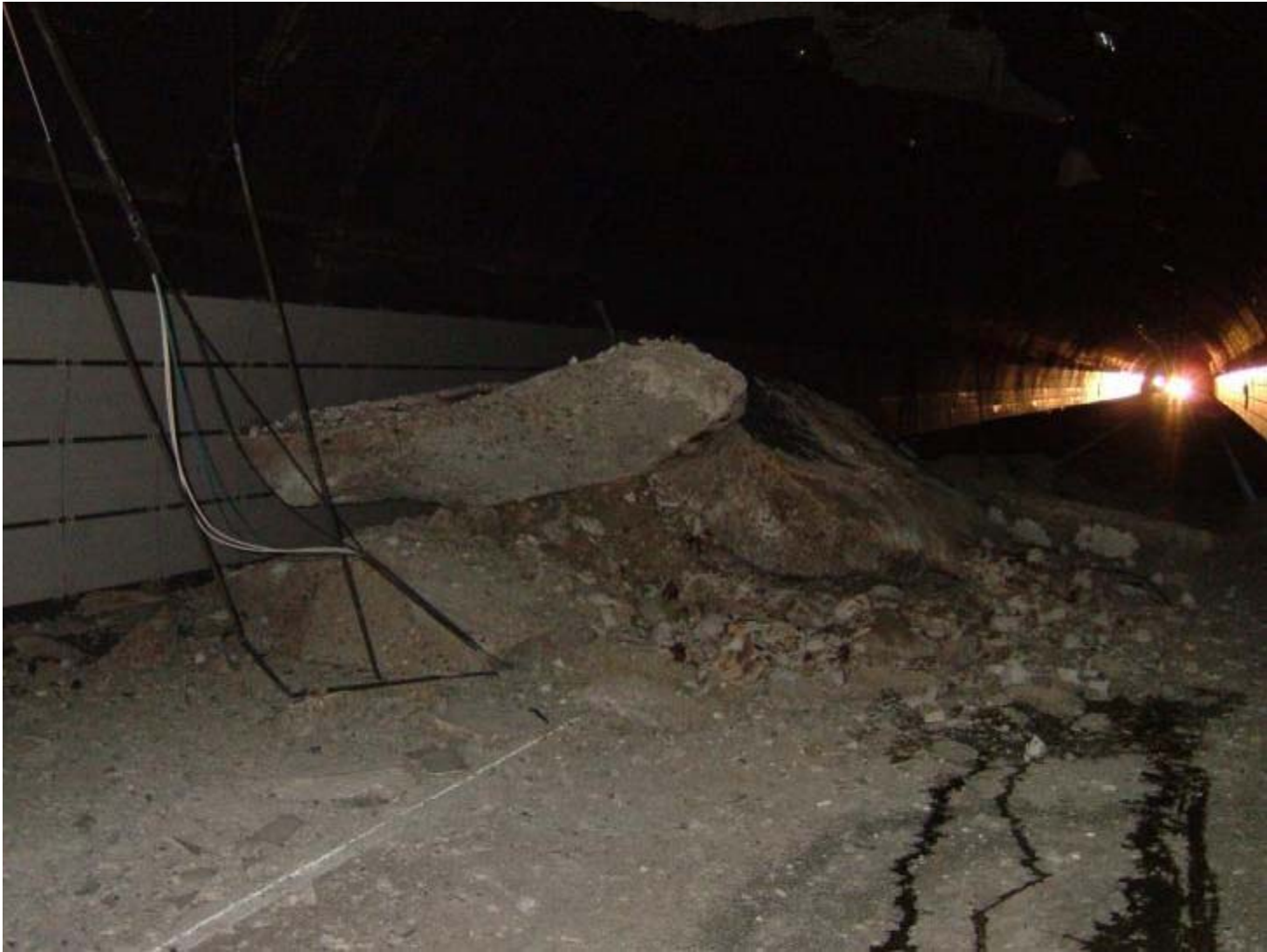
平成16年10月 新潟県中越地震（死者 68人 負傷者 4,805人） わなづ 和南津トンネル 内壁崩落状況
