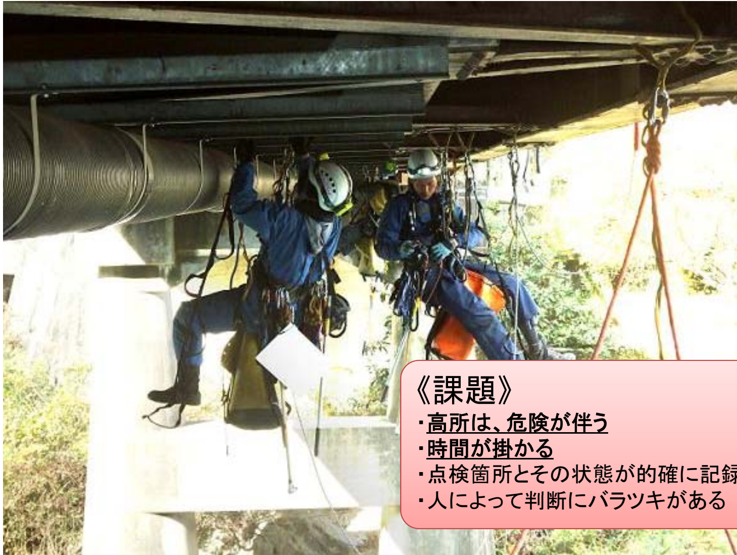
橋梁点検の実態（ロープを用いた点検）
