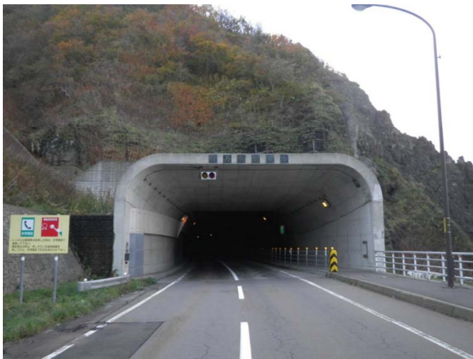
トンネル概観(起点側坑口)
