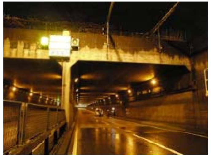
トンネル概観(下り)
