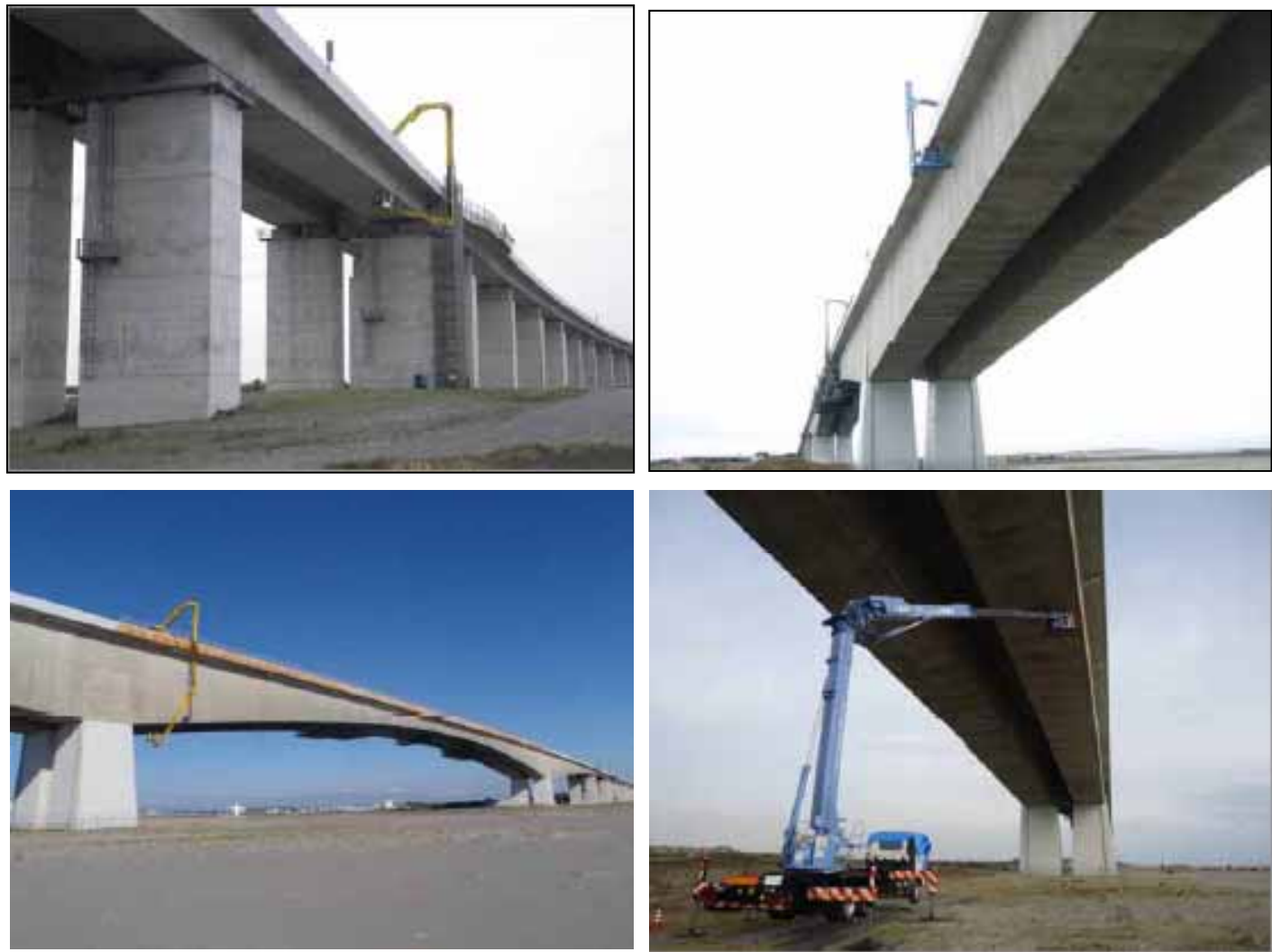
橋梁概観 (点検状況)
