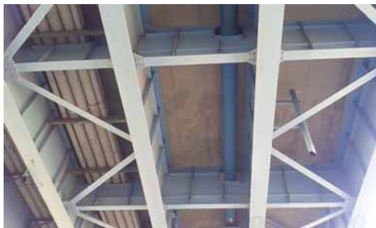
床版裏添架状況 1
