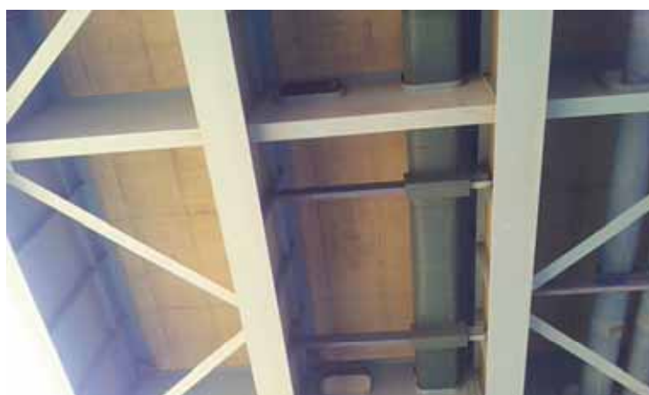
床版裏添架状況 2
