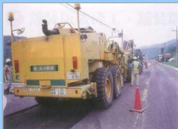
写真：路面切削作業
