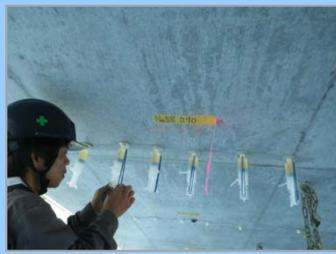
写真：ひび割れ補修工
