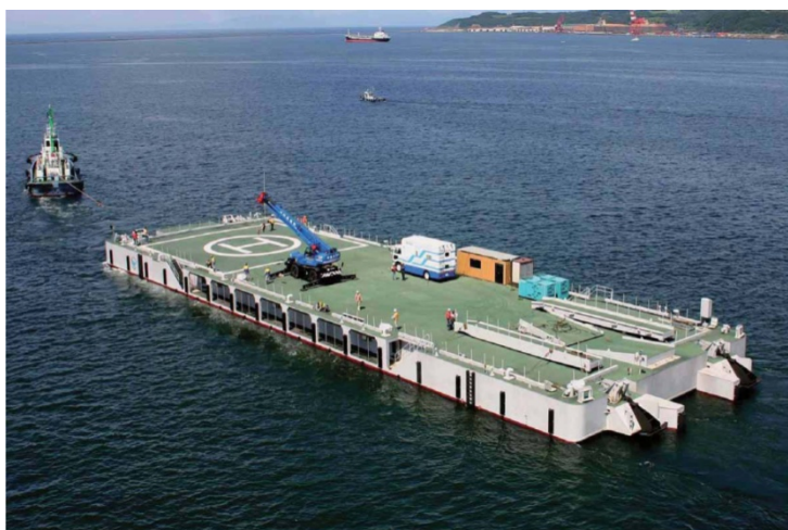
写真2 広域防災フロートの全景
