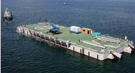
広域防災フロート全景
