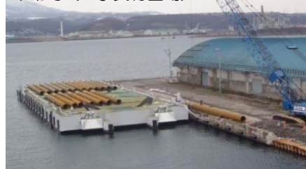
平常時（工事資材置場）
