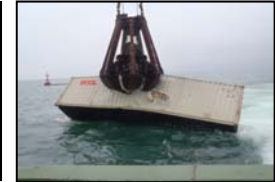
コンテナの撤去作業
