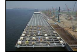
整備中の耐震岸壁
