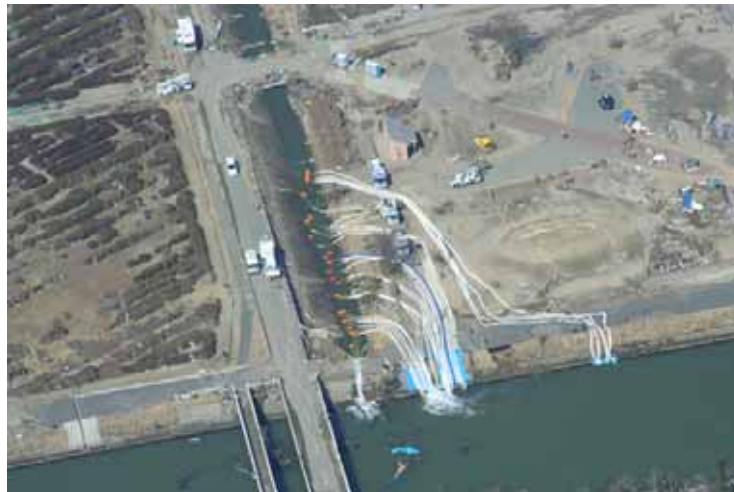
排水作業状況
