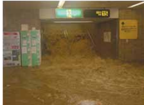
地下空間の浸水 2)
