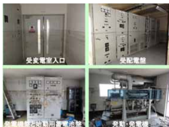
電機設備の浸水 2)
