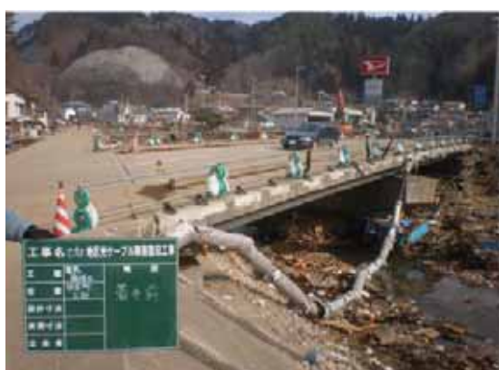
光ケーブルの切断 2)
