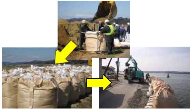
仮締め切り状況
