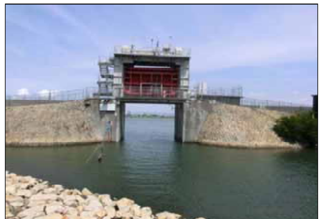
伝法水門（淀川） 遠隔化整備済み
