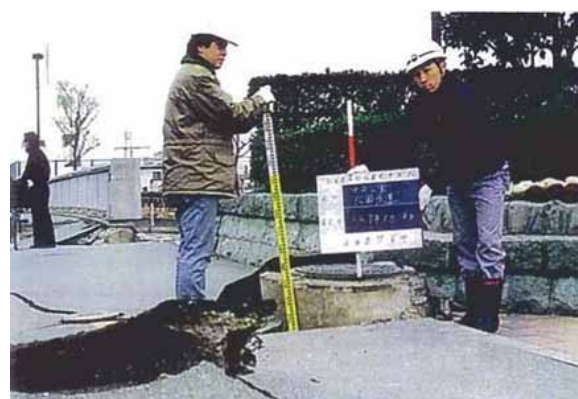
下水道の被害状況
