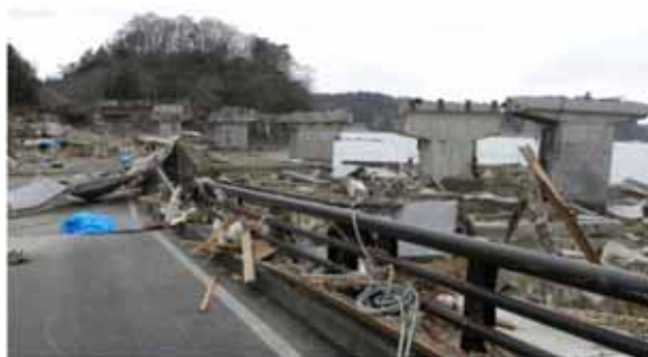
道路橋梁の被害 3)
