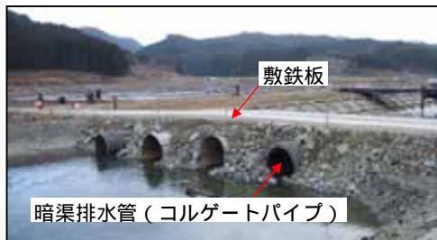
瓦礫撤去の訓練の様子(上:写真) 暗渠排水管等による仮復旧イメージ(下:写真)
