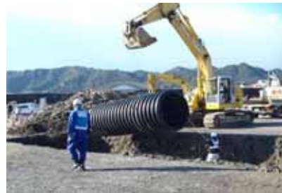
瓦礫撤去の訓練の様子(上:写真) 暗渠排水管等による仮復旧イメージ(下:写真)
