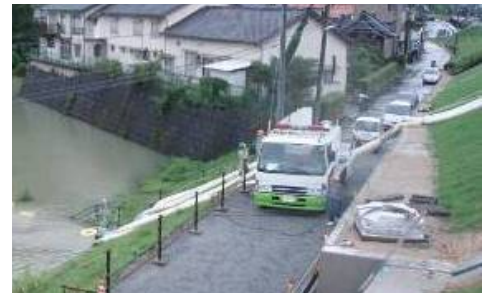
写真 2 7 浸水箇所の排水作業
