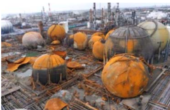
写真1：東日本大震災での東京湾臨海部におけるLPGタンクの被災状況（千葉県市原市）
