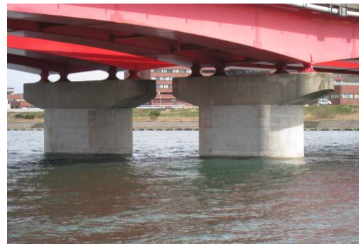
写真12 橋脚巻立ての例
