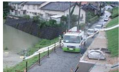
写真 2 7 浸水箇所の排水作業
