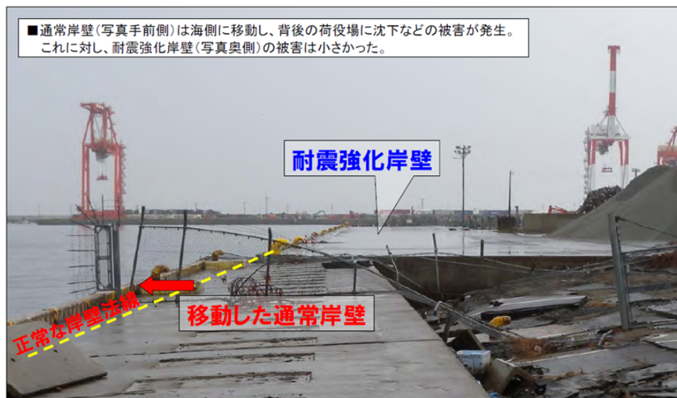
写真29 耐震強化岸壁の事例（仙台塩釜港 仙台港区）
