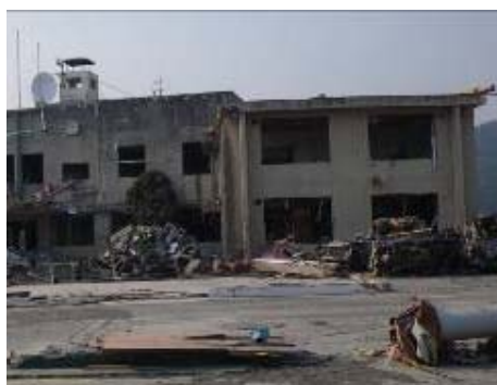
写真3 自治体庁舎の被災
