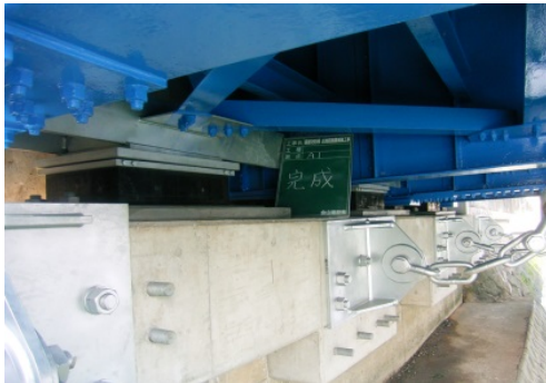
写真11 落橋防止装置の例
