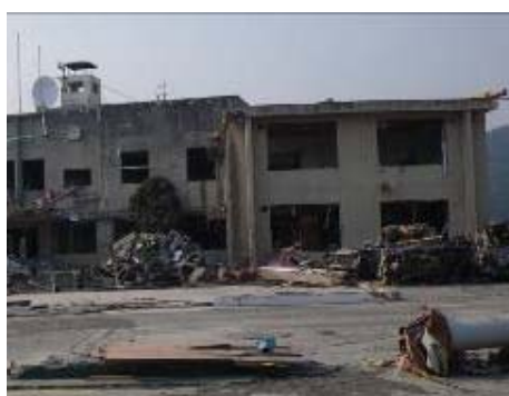
写真3 自治体庁舎の被災
