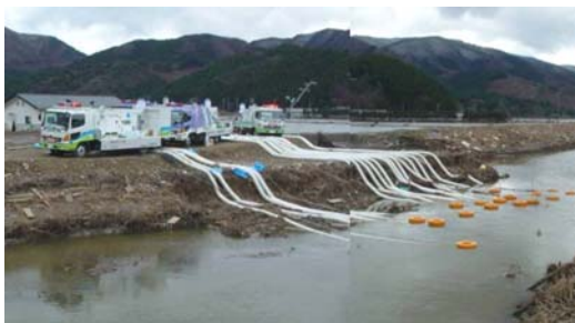
写真 2 6 浸水地域の排水作業 （石巻市釜谷）
