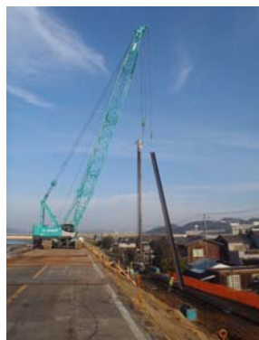
写真28 堤内側での耐震対策実施状況（高梁川左岸 距離標0k付近）
