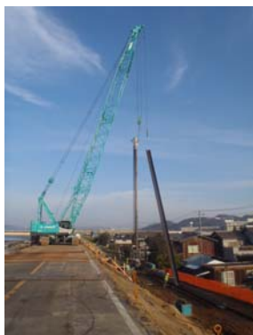
写真28 堤内側での耐震対策実施状況（高梁川左岸 距離標0k付近）
