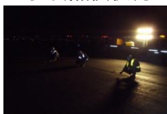
<打音点検状況>
