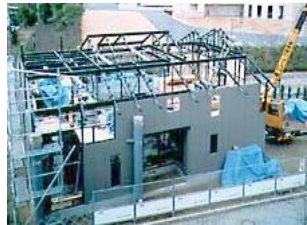
S造プレハブ工法
