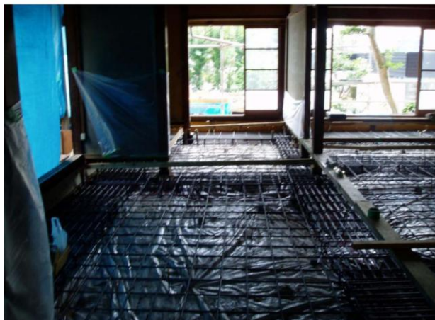
H型钢と連結するように配筋し、柱下のライン(構面)には重機が入らないために手掘りで可能な深さの溝を掘り、床梁を設ける。
