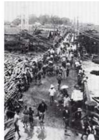
写真 11 大正 10 年の鶴岡大洪水 大泉橋から荒町方面を見たところ 倒木が橋げたにひっかかっている
