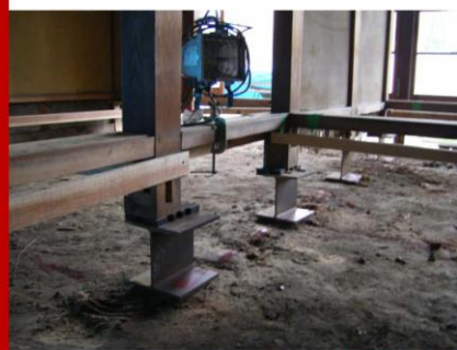
敷き土台、1階床梁(大引き)を撤去し、柱脚にH型钢を差し込む。敷居を残し水平をとる。
