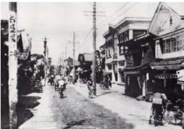
写真 14 昭和 8 年ころの荒町、上水道工事竣工
