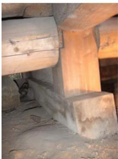
BEFORE 玉石の上に敷き土台柱の柱脚近くに床梁を設け1階床を構成している。
